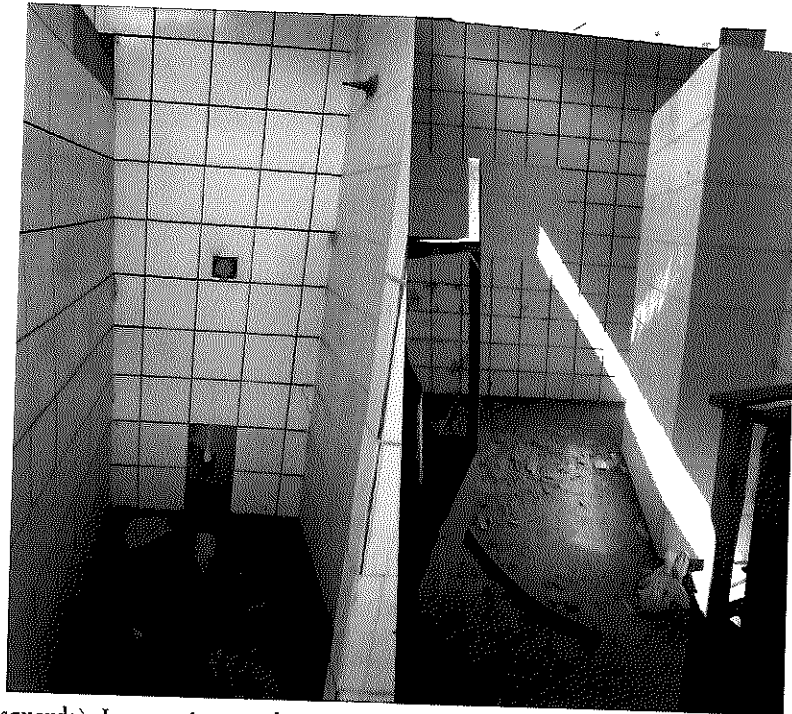
Imagem n° 07 (a esquerda): Imagem interna do sanitário. Detalhe os elementos de distribuição hidrossanitário que foram instalados, tais como válvula de descarga, tubulação de espera para instalação de vaso e registro. Imagem n° 08 (a direita): Vista da área de vestiário com piso em concreto e revestimento cerâmico aplicado nas paredes internas.
