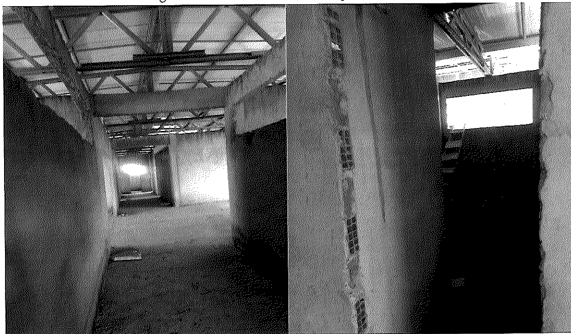
Imagens 11 e 12 – Vãos de esquadria. Necessário requadro para assentamento das portas e janelas.
