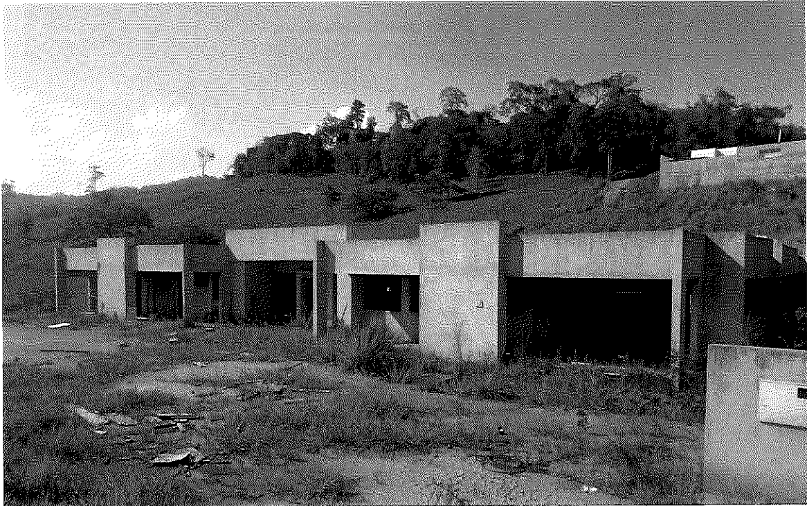
Imagem 17 – Vista da fachada da obra completamente revestida em chapisco, emboço e reboco.
