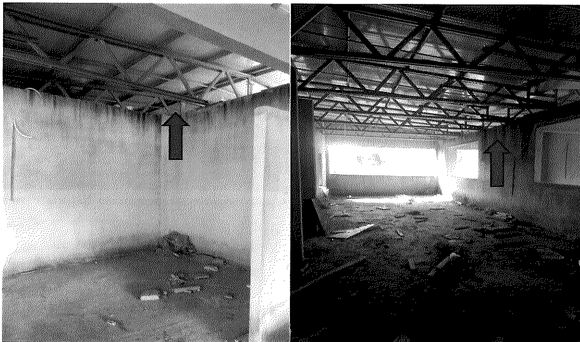
Imagens 15 e 16 – Detalhe para os elementos de cobertura executados na obra.
