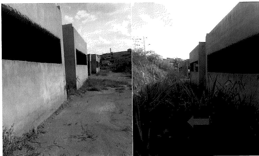
Imagem 03 (esquerda) – Vista externa que demonstra o nivelamento do terreno
