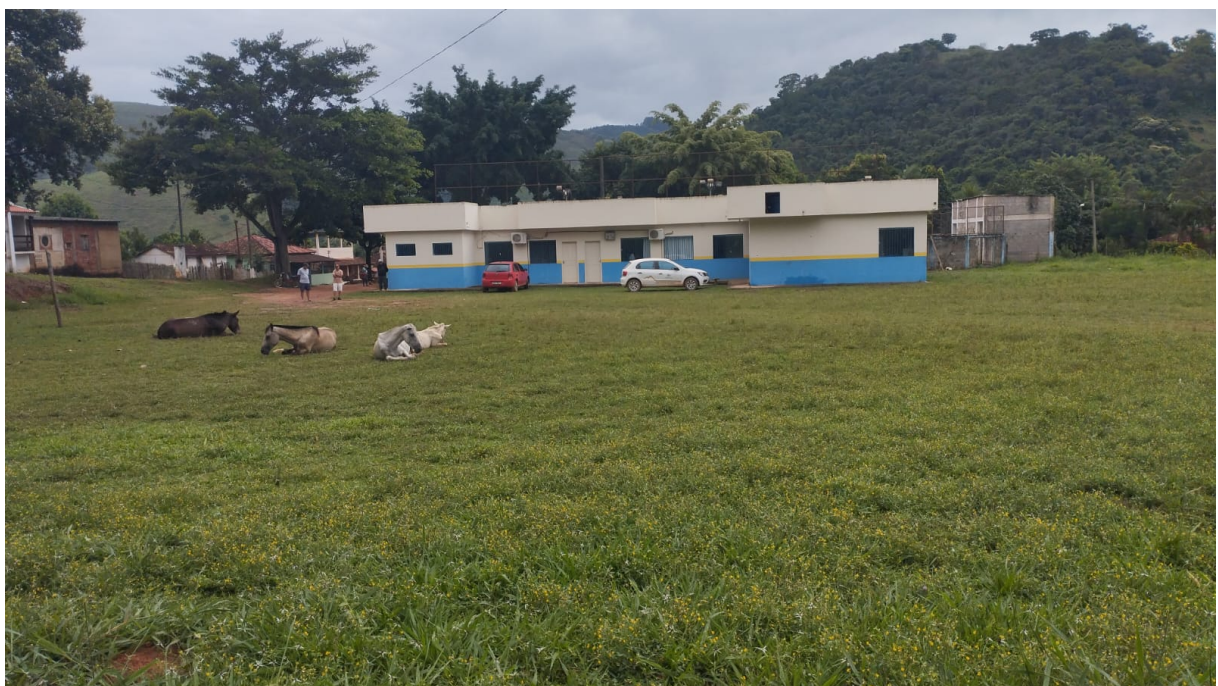
Imagens 04: Vistas do terreno. Detalhe nivelamento
